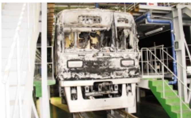
図1 放火された車両(進行方向、先頭車両)
