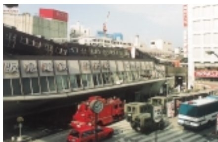
阪神・淡路大震災により崩壊した阪急伊丹駅舎
